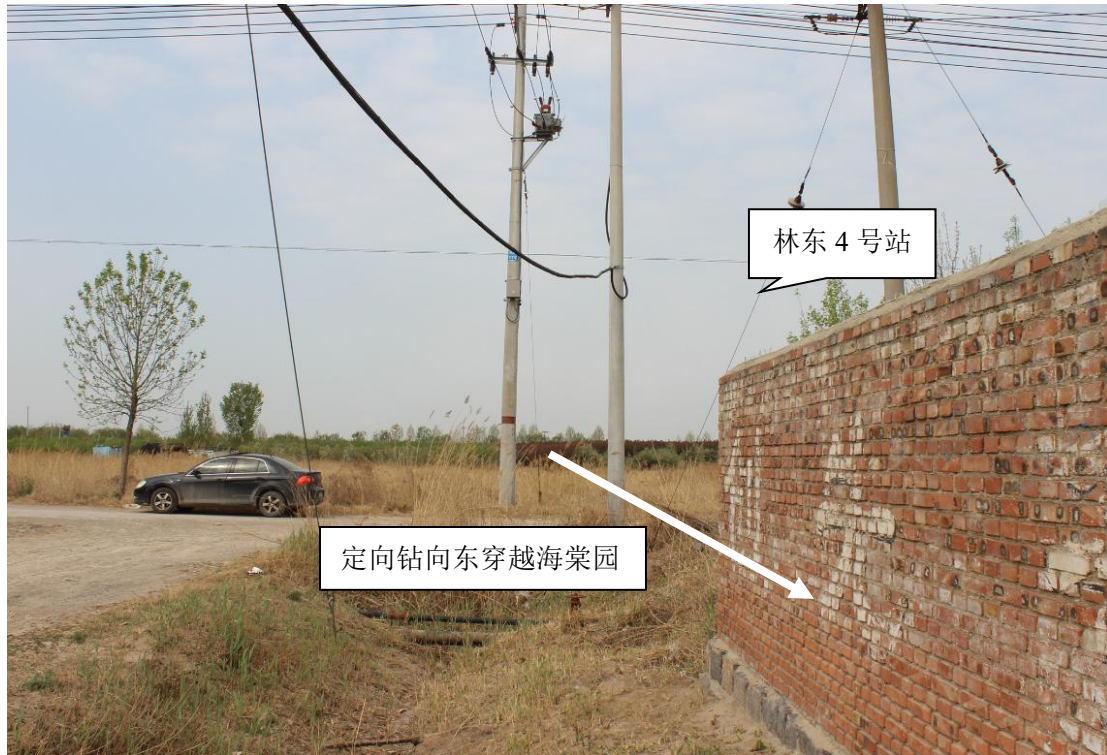
图 5.1-6 林东 8 号站-林东 4 号站注水干线走向现场图 6
