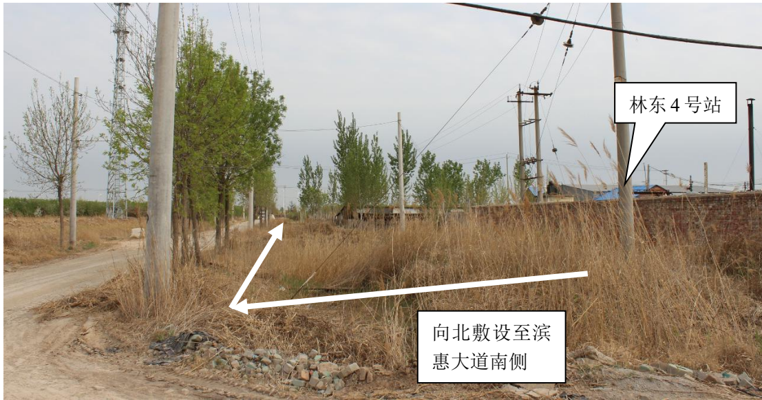
图 5.1-7 林东 4 号站-林东 2 号站走向现场图 1
